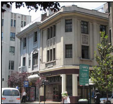
Fotografía de fachada
