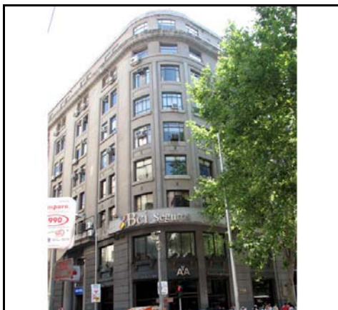
Fotografía de fachada
