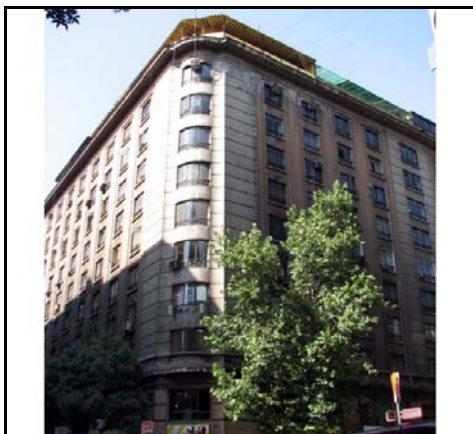
Fotografía de fachada
