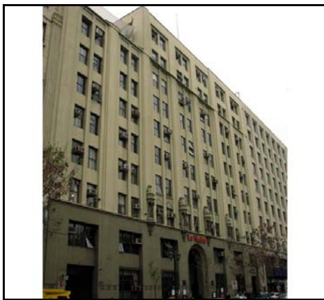
Fotografía de fachada
