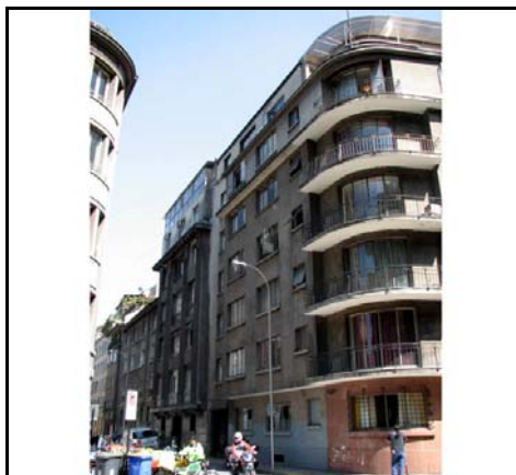
Fotografía de fachada
