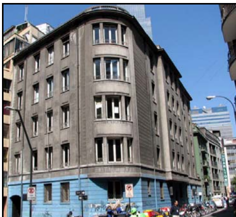
Fotografía de fachada
