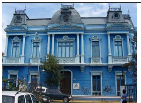
Fotografía de fachada
