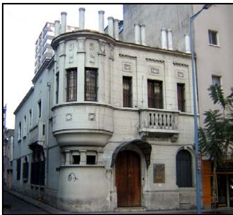
Fotografía de fachada
