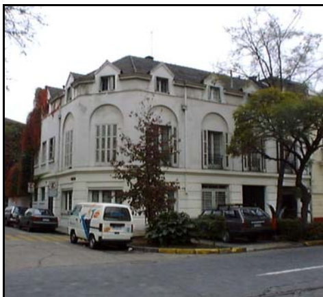
Fotografía de fachada
