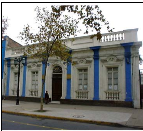
Fotografía de fachada
