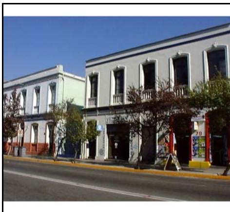
Fotografía de fachada
