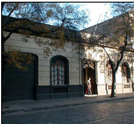
Fotografía de fachada
