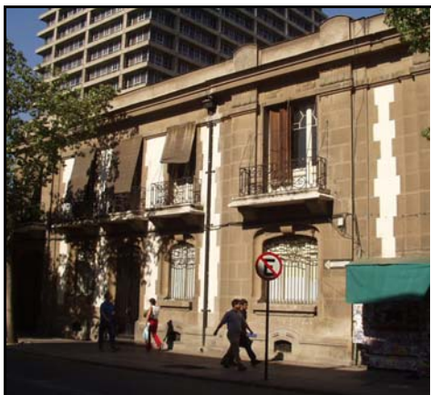
Fotografía de fachada
