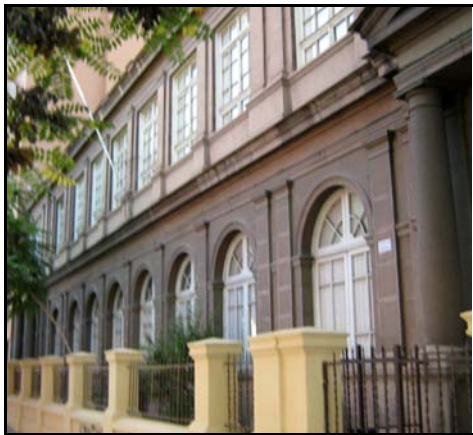
Fotografía de fachada
