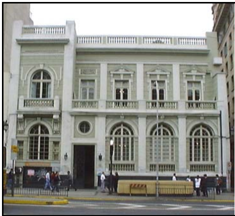
Fotografía de fachada
