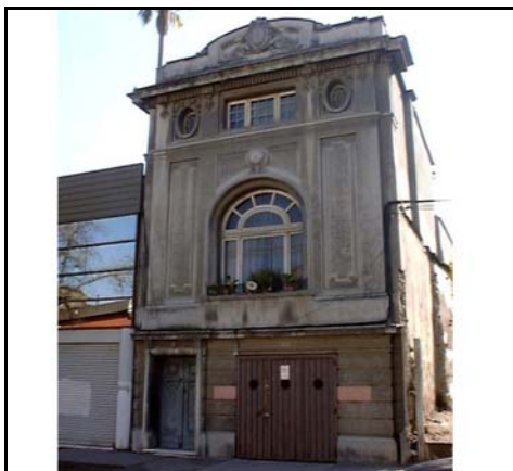
Fotografía de fachada
