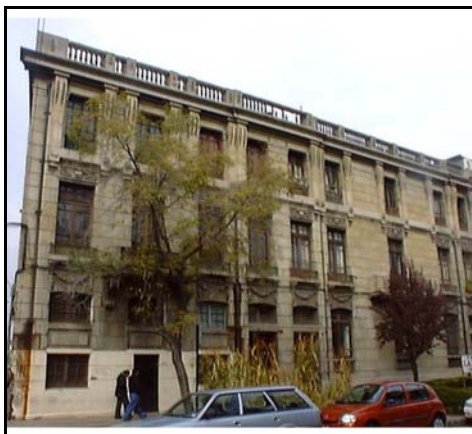
Fotografía de fachada
