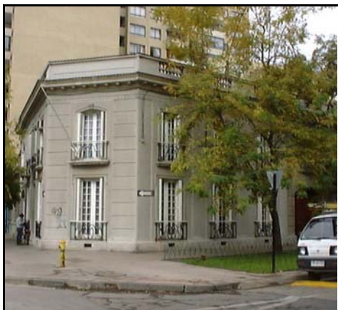
Fotografía de fachada
