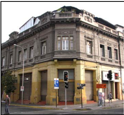
Fotografía de fachada
