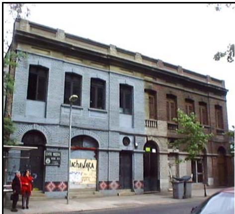
Fotografía de fachada
