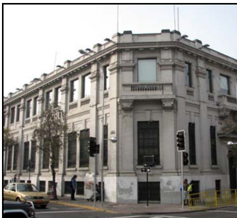
Fotografía de fachada
