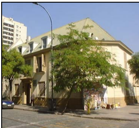
Fotografía de fachada
