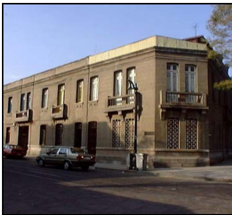
Fotografía de fachada
