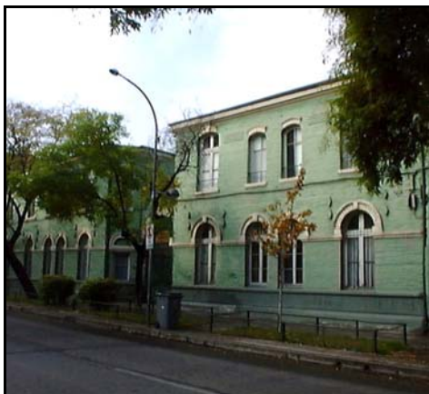
Fotografía de fachada
