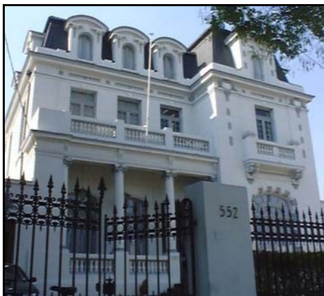
Fotografía de fachada
