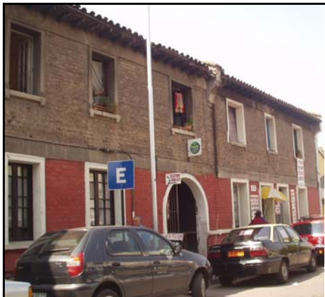
Fotografía de fachada
