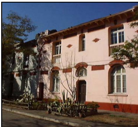
Fotografía de fachada
