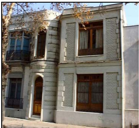
Fotografía de fachada
