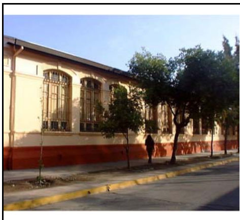
Fotografía de fachada
