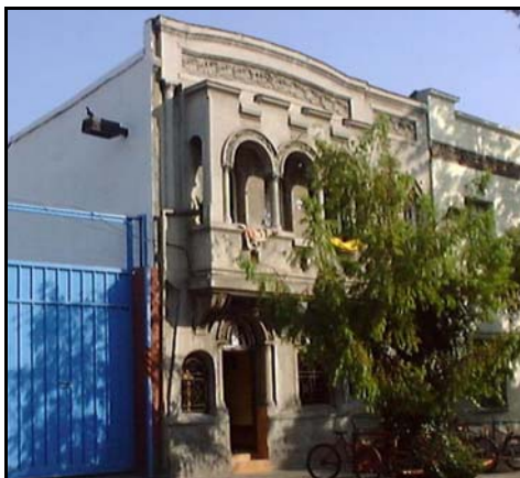
Fotografía de fachada
