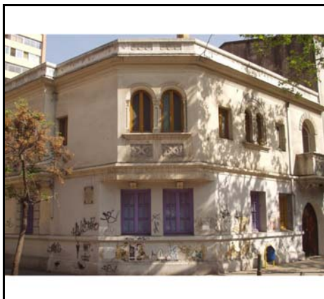
Fotografía de fachada
