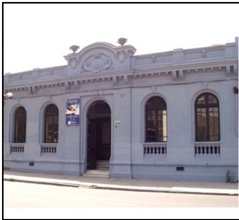
Fotografía de fachada
