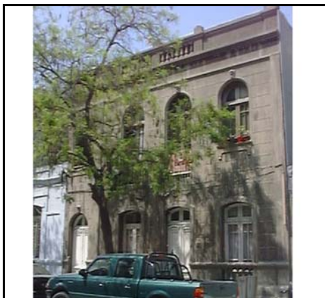
Fotografía de fachada
