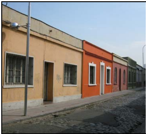
Fotografía de fachada
