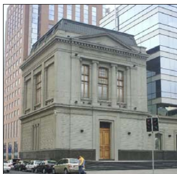
Fotografía de fachada
