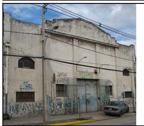
Fotografía de fachada
