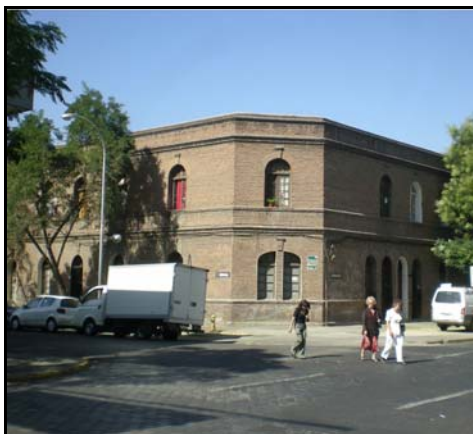
Fotografía de fachada
