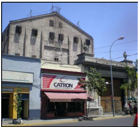
Fotografía de fachada
