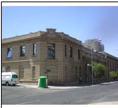
Fotografía de fachada
