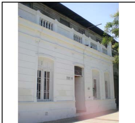
Fotografía de fachada
