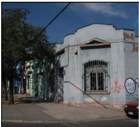
Fotografía de fachada
