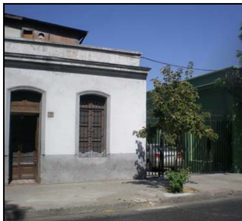
Fotografía de fachada
