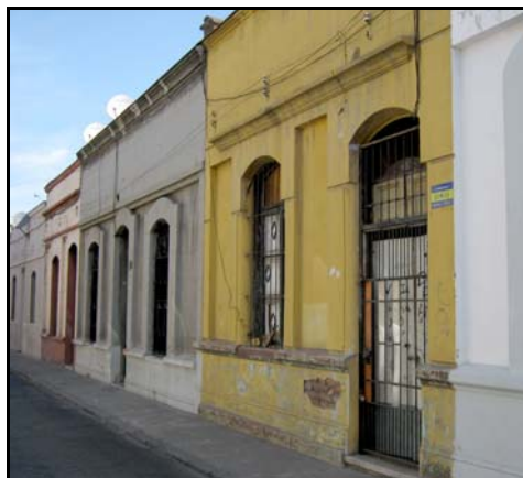
Fotografía de fachada
