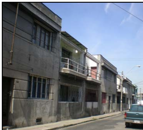
Fotografía de fachada
