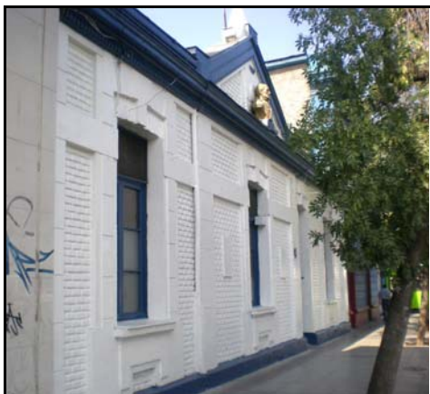
Fotografía de fachada
